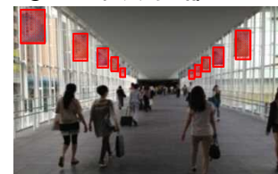
② 東口2階デッキ内部 仮設部分
